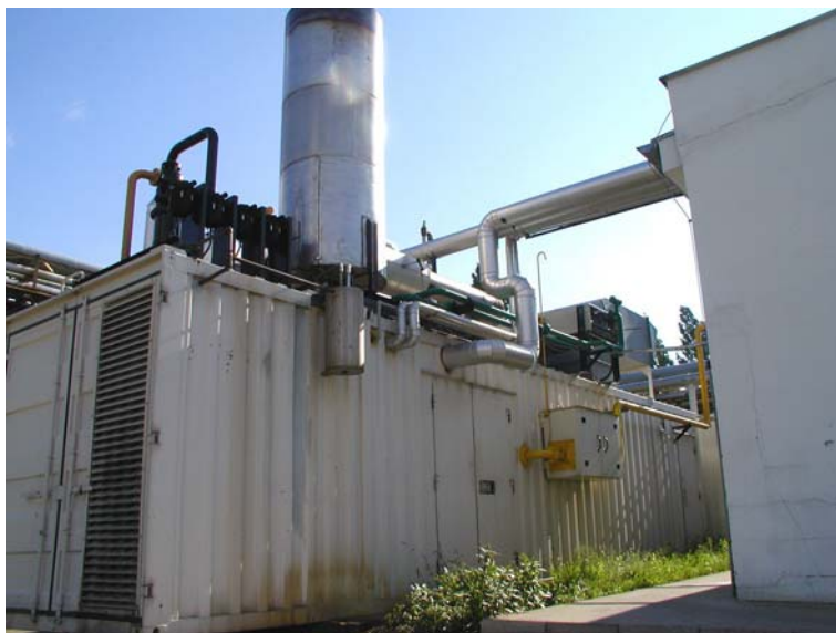
Obr. 5.11: KJ TEDOM CAT 1000 SP bio instalovaná v roce 2003 je umístěna ve venkovním kontejneru
