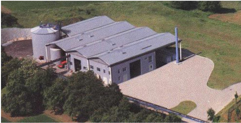
Obr. 2.29: Bioplynová stanice na zpracování BRKO ve městě Karlsruhe
