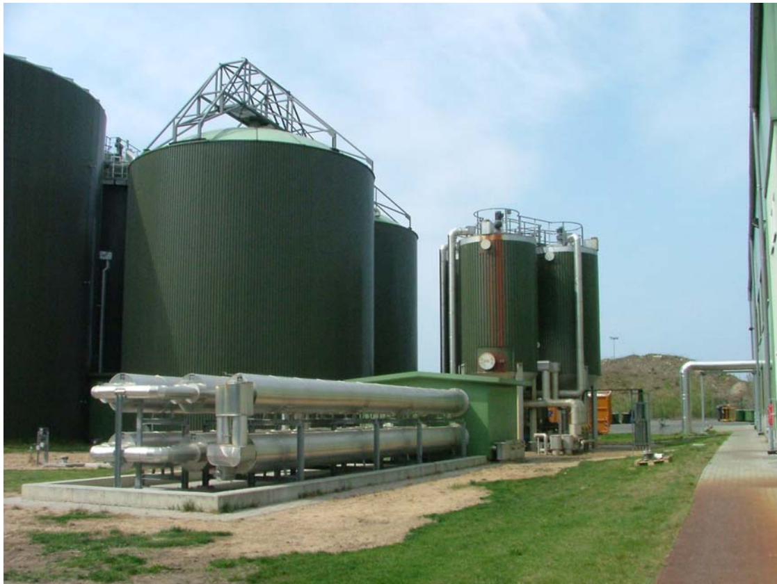
Obr. 5.5: Jednotka pro termickou úpravu BRKO, bioplynová stanice Alteno u města Duben, SRN
