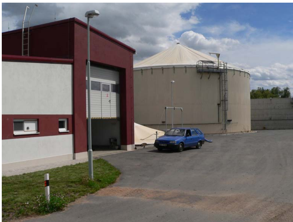
Obr. 5.1: Bioplynová stanice Kněžice, celkový pohled
