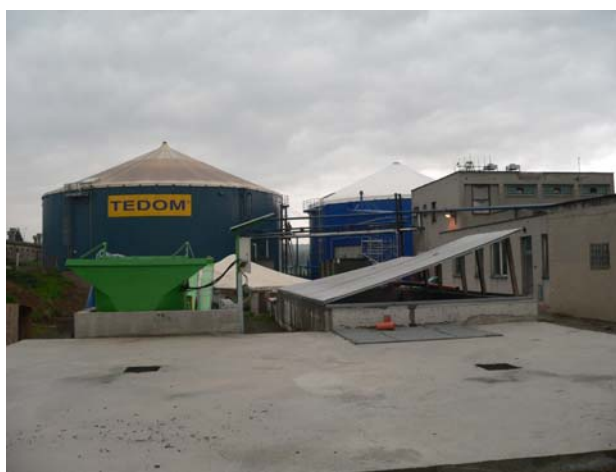
Obr. 3.1: Textilní dvouplášťový nasedlaný plynojem, obvykle polyesterová tkanina + PVC, nízkotlaký 0,5 – 2,5 kPa, životnost 20 – 30 let nabízí řada firem, v ČR např. Tomášek SERVIS s.r.o.
