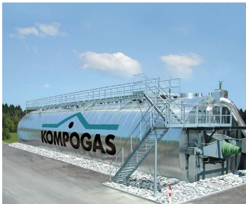
Obr. 2.13: Kombinovaný systém bioplynové stanice pro zpracování tuhých materiálů firmy Kompogas [48]
