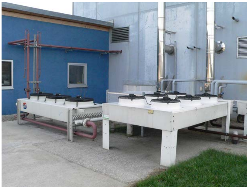
Obr. 3.3: Bezpečnostní plynový hořák Obr. 3.4: Chladiče pro chlazení motoru kogenerační jednotky
