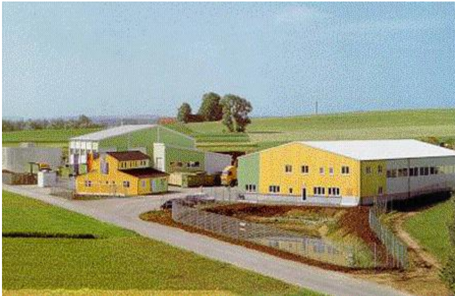
Obr.2.27: Bioplynová stanice BIO-Energie Schwaben v Erkheimu SRN
