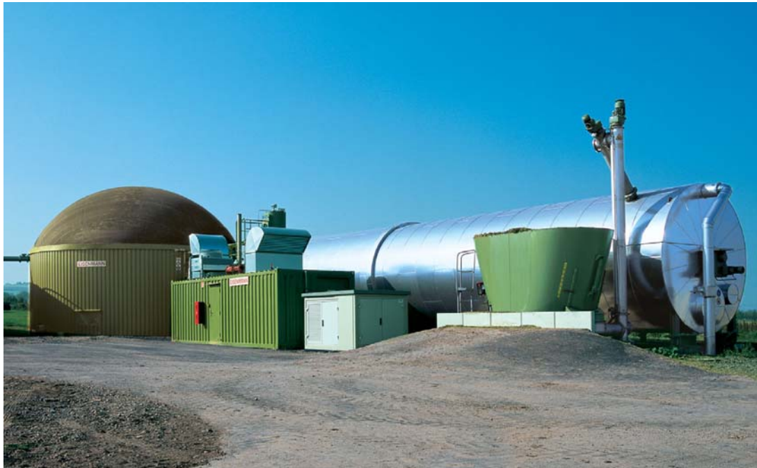
Obr. 2.14: Kombinovaný systém bioplynové stanice pro zpracování tuhých materiálů firmy Archea [49]
