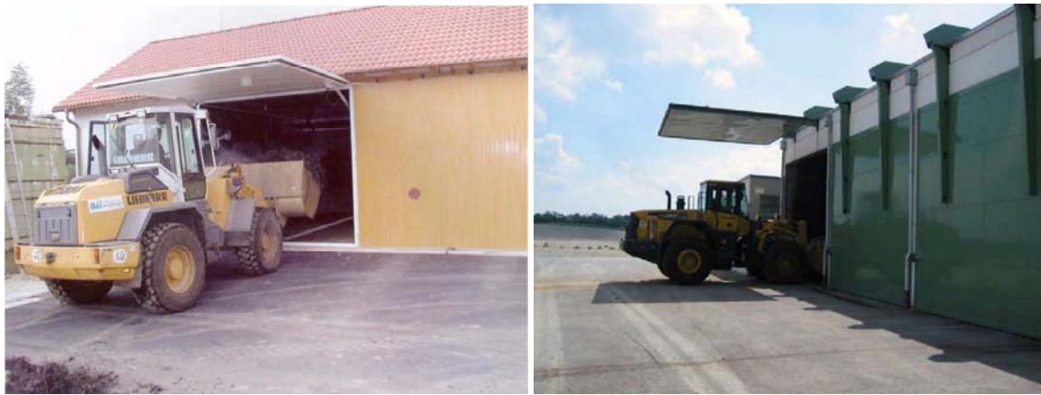
Obr. 2.10: Garážový systém fermentorů na tuhý organický materiál [47]
